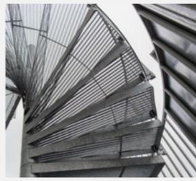
Treppenstufen von GTM sind in einem Stück gefertigt, für garantierte Qualität aus einem Guß. Bei GTM haben Sie Stufe für Stufe sicheren Boden unter den Füßen. Wir verwenden serienmäßig ausschließlich RAL gütegeschützte Gitterroste mit TÜV und BG geprüfter rutschhemmender Oberfläche.
