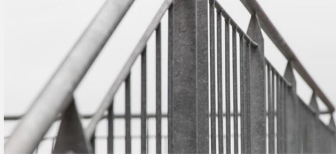
An Geländern steht Ihnen bei GTM ein breites Sortiment aus feuerverzinktem Stahl in ansprechender Optik zur Verfügung. Sie können zwischen Standardgeländern der Ausführungen A, B, C und D in den Höhen 1 m und 1,10 m und zwischen 0,5 oder 1,0 kN/m Holmdruck DIN EN 1991-1-1 wählen. Alle Geländer werden gesteckt und verschraubt und sind somit sehr sicher und problemlos zu montieren.
